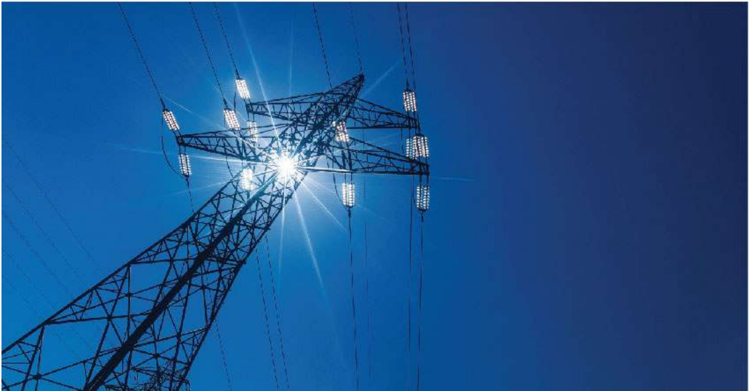
Torre de alta Tensión
