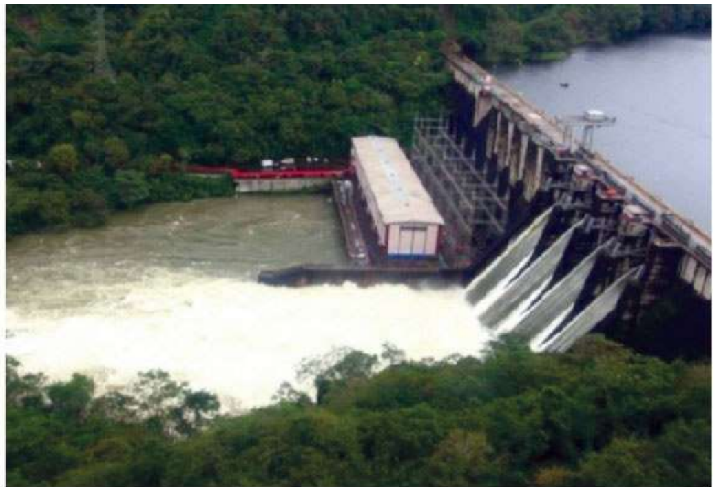
Hidroeléctrica de Bayano
