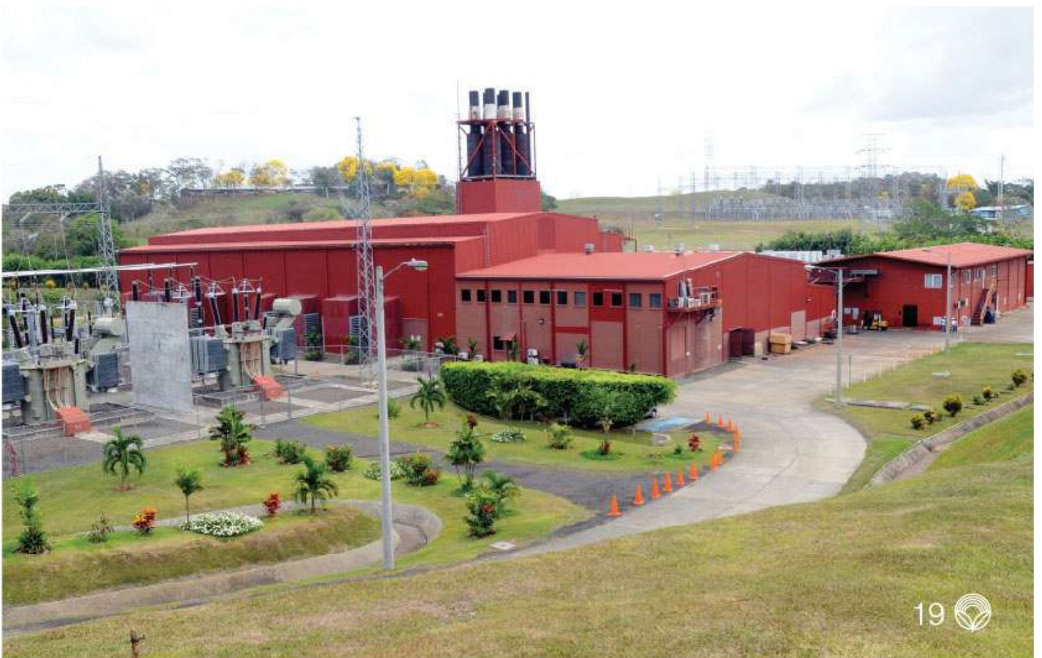
Planta Pan Am Generating Ltd.
