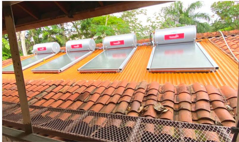
Los calentadores solares de agua, al no necesitar quemar gas o diésel para su funcionamiento, ayudarán a evitar la emisión de 1.72 toneladas de dióxido de carbono equivalente (CO<sub>2</sub>e) al año.
